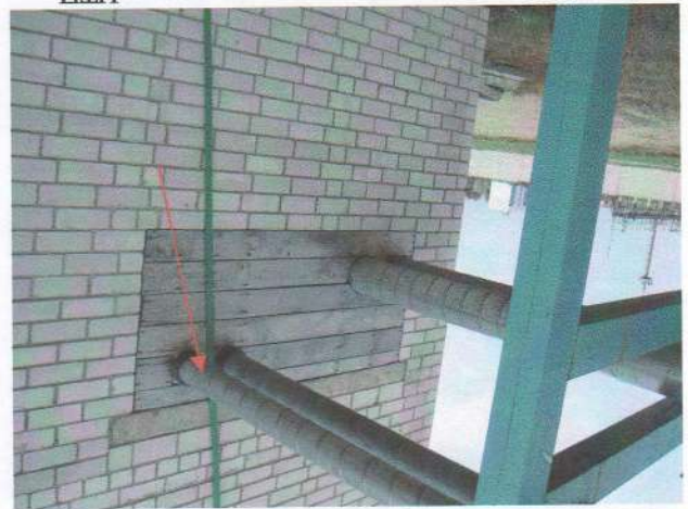
Рис. 1 Место выхода теплосети из здания ЦТП
