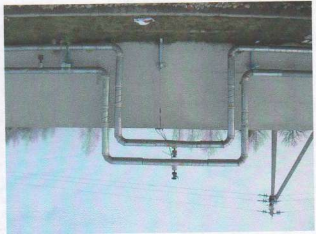
Рис. 11 Переход теплотрассы через автодорогу на территории КСМ
