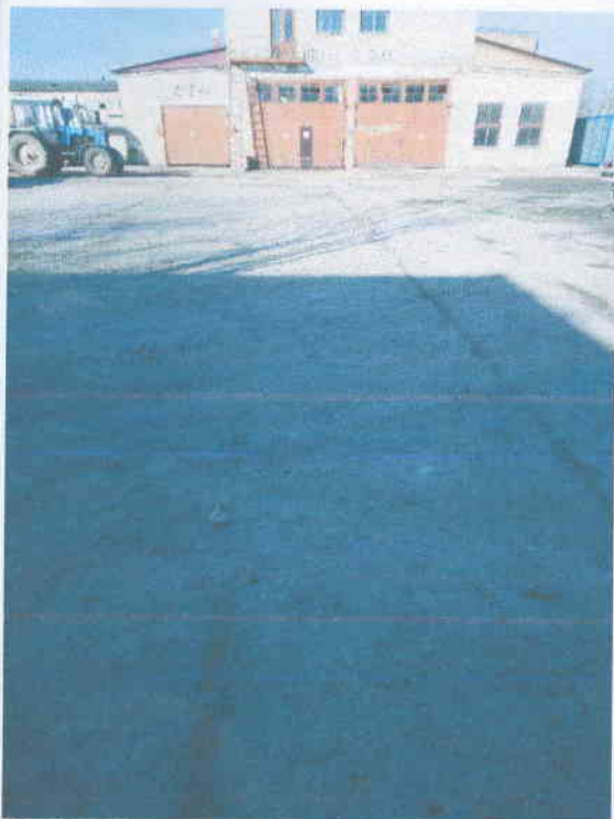
03.03.2022 г. литер а Покрытие (участок 1)
