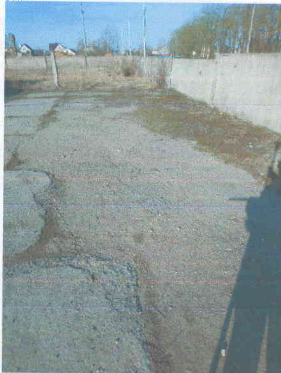
03.03.2022 г. литер а Покрытие (участок 2)
