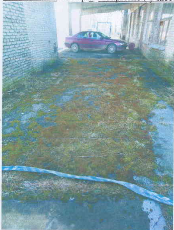
03.03.2022 г. литер а Покрытие (участок 3)
