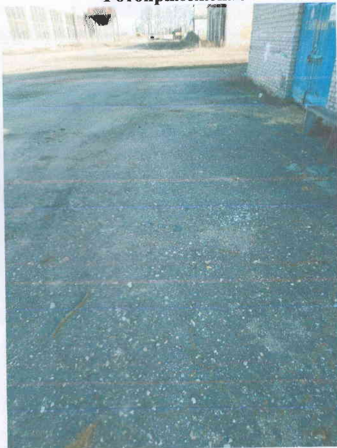
03.03.2022 г. литер а Покрытие
