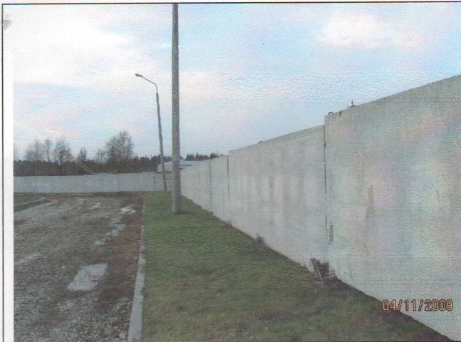
Рис1. Ограждение территории (вид 1)
