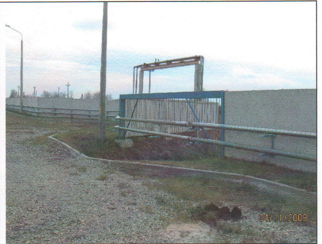
Рис2. Ограждение территории (вид 2)
