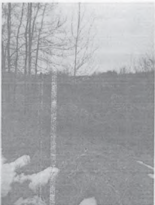
03.03.2022 г. литер б Ограждение (участок 3)
