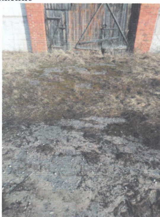
03.03.2022 г. литер а Покрытие (участок 2)
