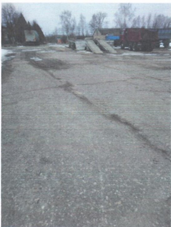
03.03.2022 г. литер а Покрытие (участок 1)
