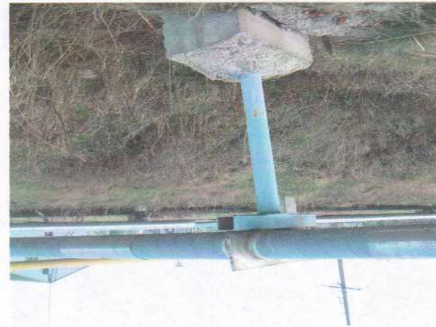
Рис. 1 Место врезки в магистральную теплотрассу
