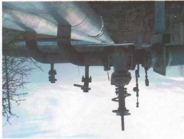
Рис. 1 Место врезки в магистральную теплотрассу
