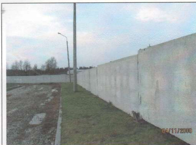
Рис1. Ограждение территории (вид 1)
