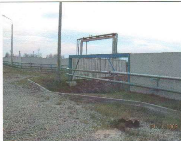
Рис2. Ограждение территории (вид 2)
