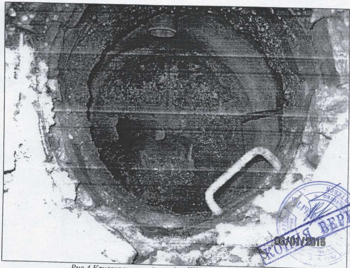
Рис. 4 Канализационный колодец КК1
